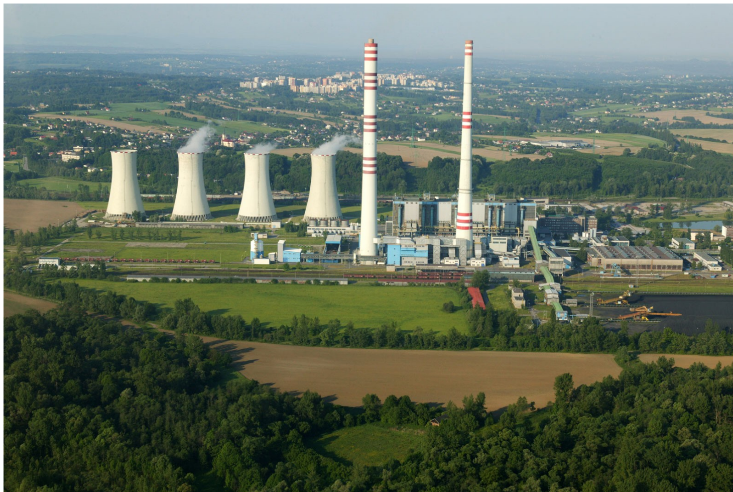
UHELNÁ ELEKTRÁRNA DĚTMAROVICE
